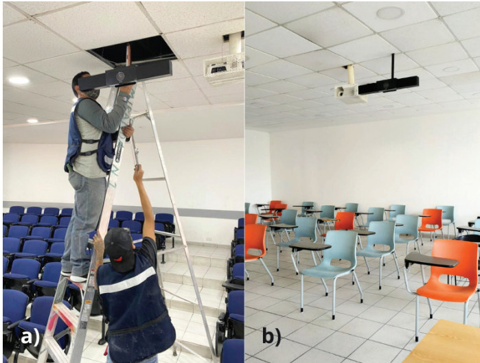
Figura 2. Sistema Poly Studio. a) Instalación en las aulas y auditorios. b) Vista del sistema en las aulas de la Facultad de Medicina.
